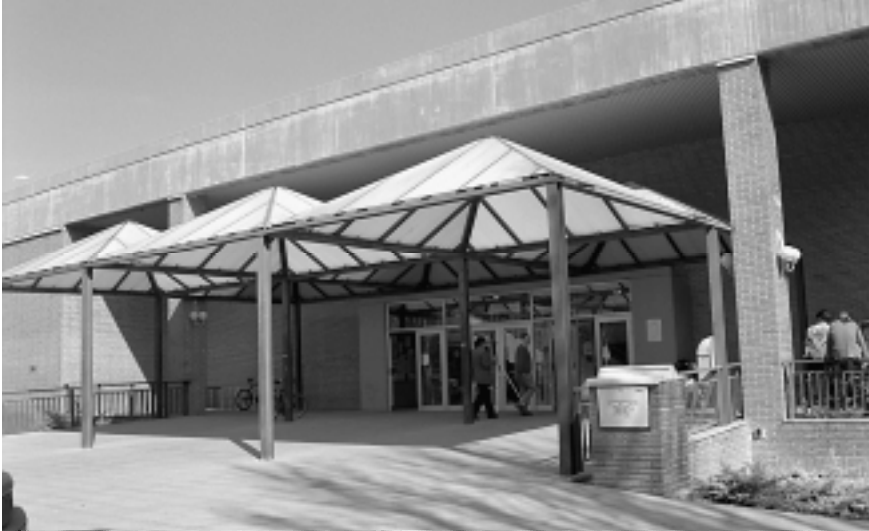
Vista parcial del Aulario. Entrada Principal (1998).
