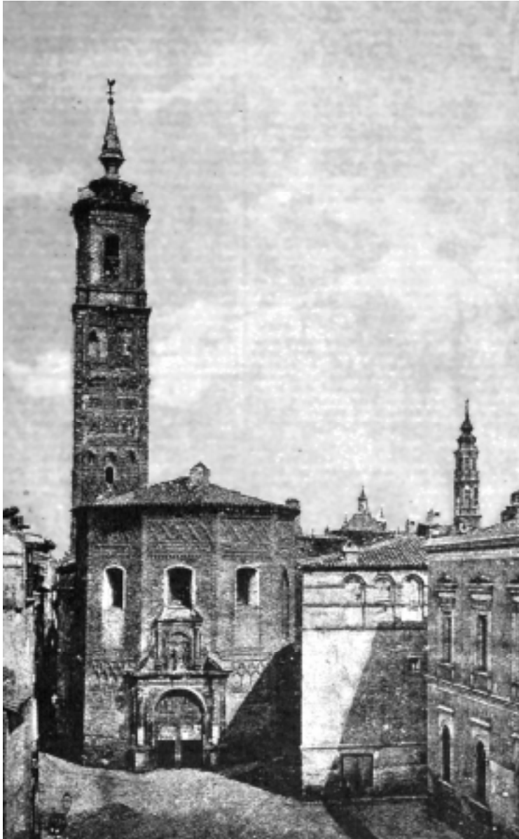
Conjunto arquitectónico tal como lo vio por primera vez Anastasio Ortiz. La Torre de la Iglesia de la Magdalena muestra el recacimiento barroco que construyó el arquitecto Yarza sobre la antigua torre mudéjar. La fachada de la Universidad literaria presentaba este aspecto hasta que fue remodelada bastantes años después. Junto a esta plaza, en la calle Mayor, n.º 59, estuvo situada la 1ª sede de la Escuela de Veterinaria.
