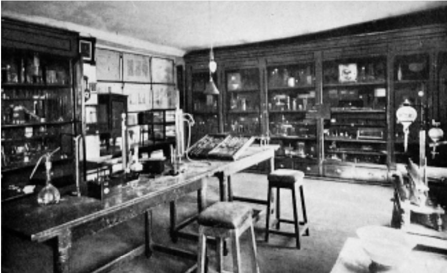
Laboratorio de Fisiología e Higiene hacia el año 1920. Sin embargo en esta etapa y después del apuntalamiento de las aulas del piso calle, se prohibió el ingreso masivo de estudiantes. Sólo se podía entrar de tres en tres.
